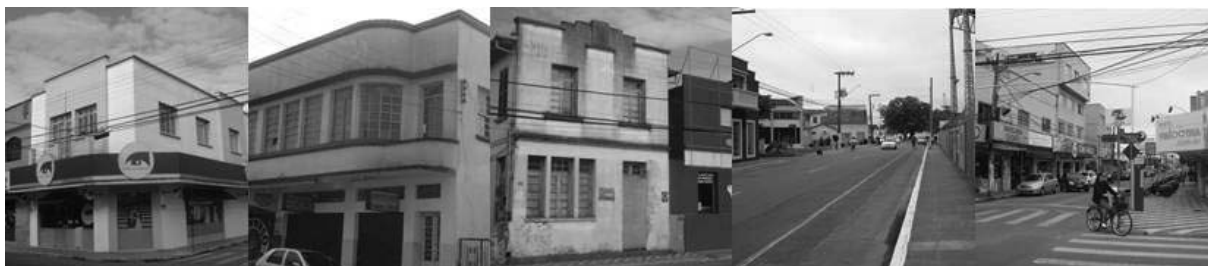
Figura 9 – Perspectiva da caminhada da início da Rua Tijucas até o Largo da Matriz do Santíssimo Sacramento, junto ao conjunto arquitetônico do início do século XX.
