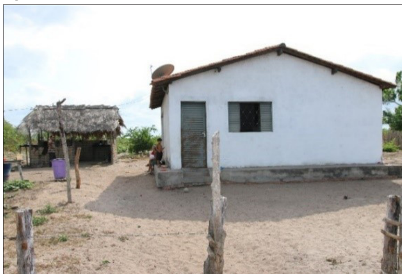
Figura 2 – Casa do PMCMM e cozinha autoconstruída em anexo
