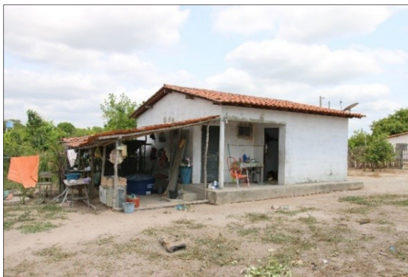
Figura 1 – Casa do PMCMM com construção de alpendre
