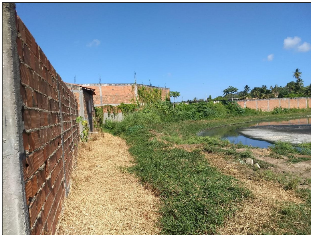
Figura 5 – Ocupação nas margens da ETE
