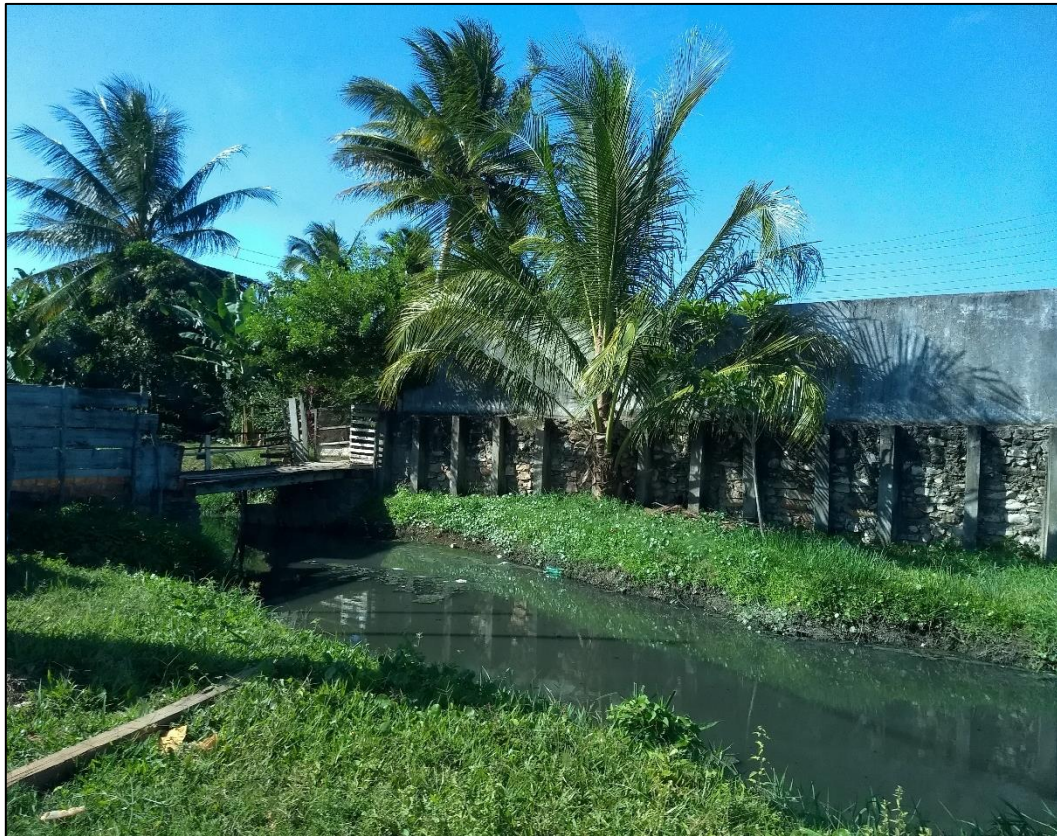
Figura 4 – Córrego que enfrenta o lançamento de esgoto
