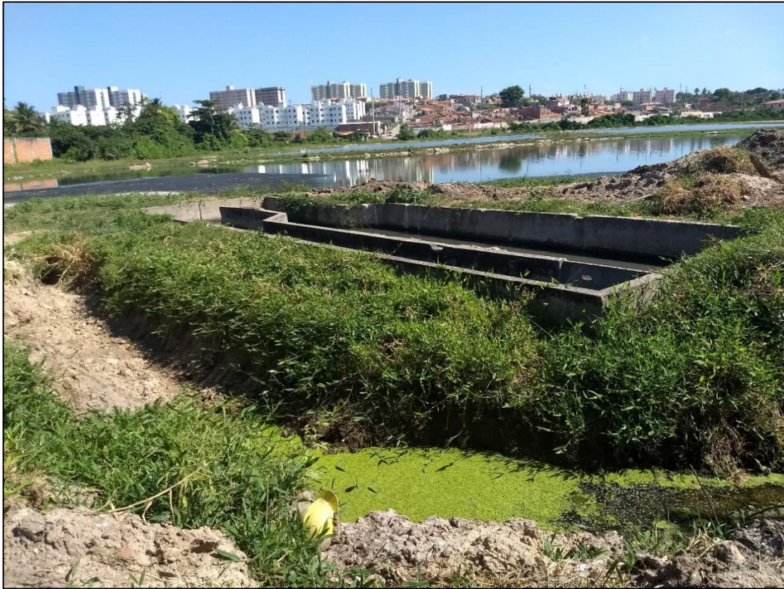
Figura 6 – Aparecimento de condomínios no entorno da ETE
