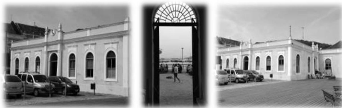
Figura 13 – Mercado Público, fachadas e pórtico.
