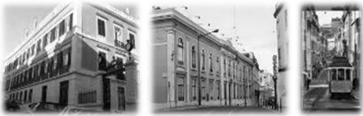
Figura 3 – Fachadas dos edifícios das ruas A, B e C, respectivamente.
